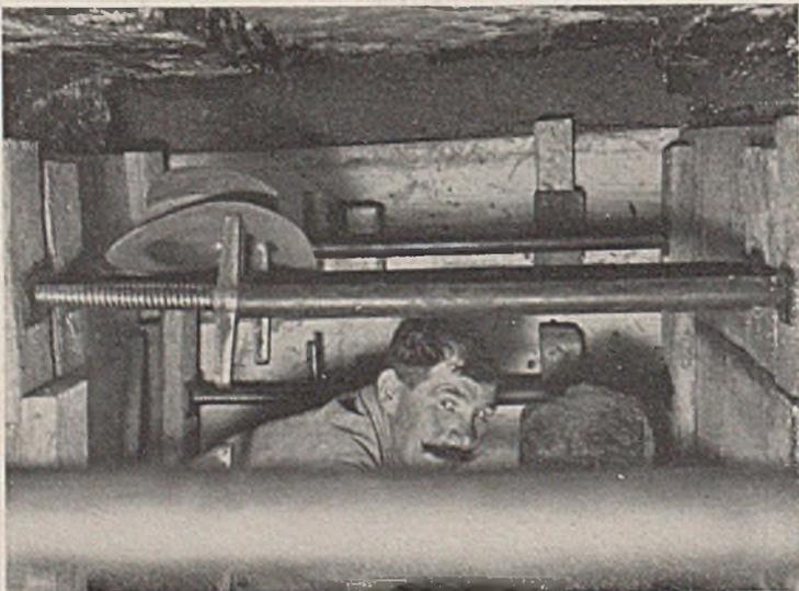
Abb. 5. Spritzung für den Aushub eines Blockes.
