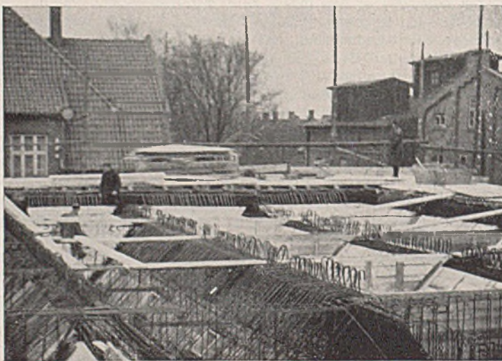
Abb. 8. Eiseneinlagen der Trichter, rechts sind bereits die Deckelschalungen eingebracht.
