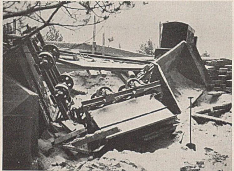
Abb. 4. Über das nicht gesicherte Gleisende hinübergefahren und abgestürzte Feldbahnwagen (Vortrag Roloff).
