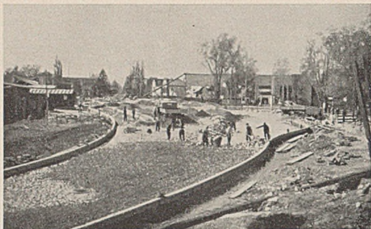
Abb. 53. Straßenbauarbeiten an der rechtsufrigen Rampe.
