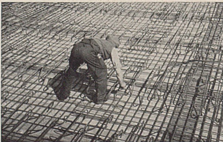
Abb. 45. Eisenbewehrung der Fahrbahnplatte der Straßenbrücke.
