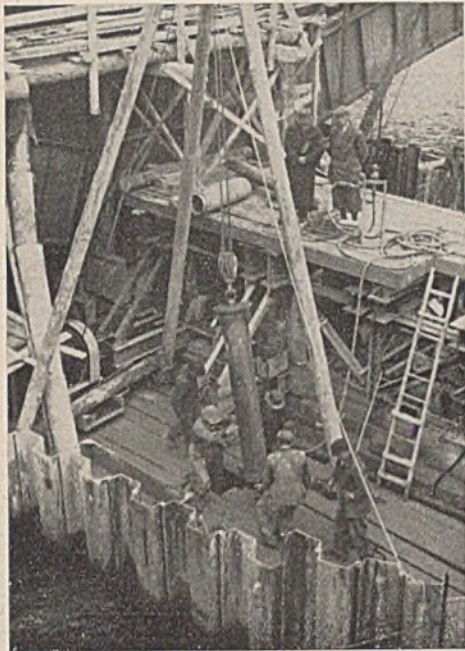
Abb. 15. Niederbringen der Bohrröhre für die Preßbetonpfähle der Pfeilerunterfangung.
