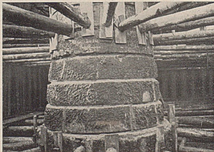
Abb. 14. Das alte Mauerwerk eines trockengelegten Pfeilers mit Spundwandabstützung.
