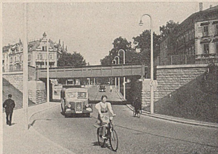
Abb. 54. Westansicht der Eisenbahnüberführung über die rechtsufrige Zufahrtstraße.
