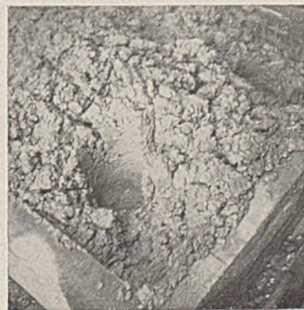
Abb. 17. Rüttelbeton mit zuviel feinsten Teilen.
