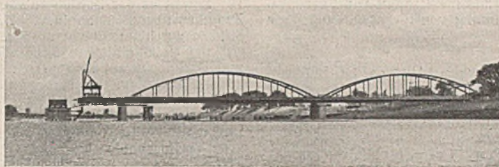
Abb. 12. Beginn des Aufbaues der Drehbrücke.
