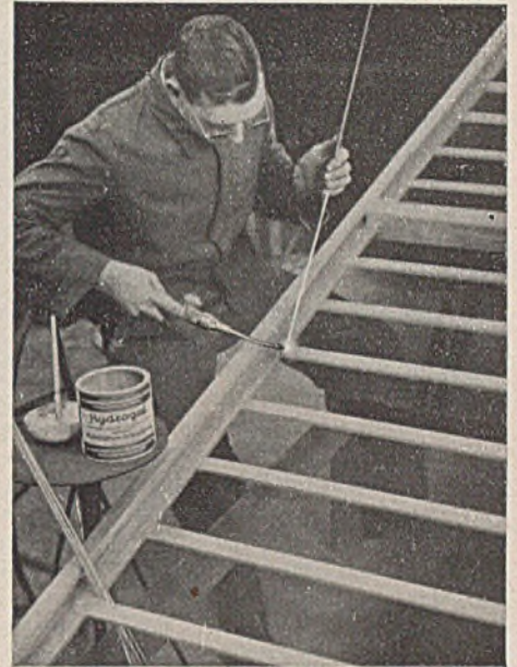
Abb. 23. Gasschweißen eines Brückengeländers aus Hydronalium mit „Hydrogal“ (von Griesogen).
