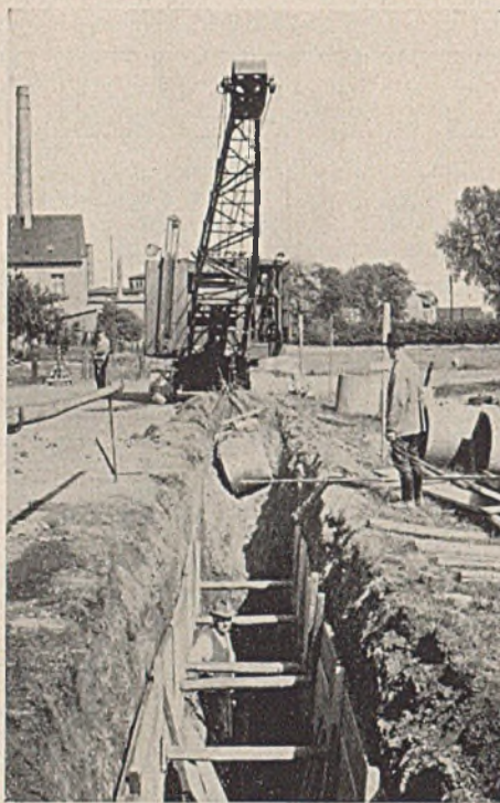
Abb. 1. Schlepsschaufelbagger der Demag beim Ausheben eines Grabens für eine Abwasserleitung.
