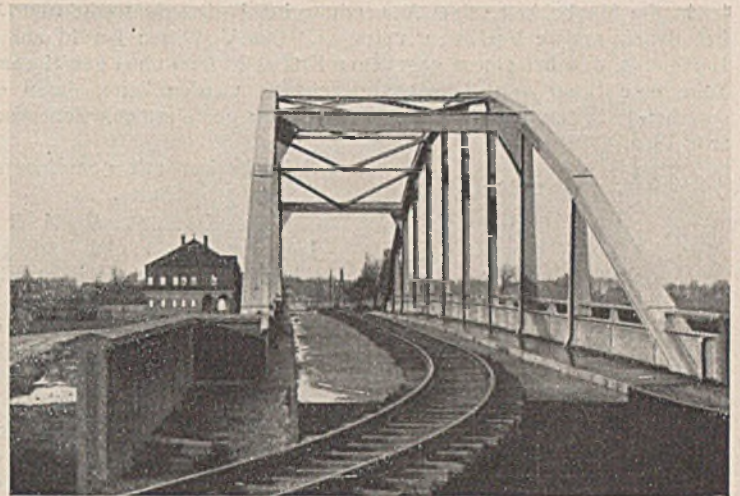
Abb. 8. Hilfsgleis für die Probelastung.
