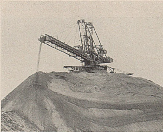
Abb. 1. Unterteilte Absetzeinrichtung (1900 m 3 /h Leistung) beim Vortreiben eines Dammes.
