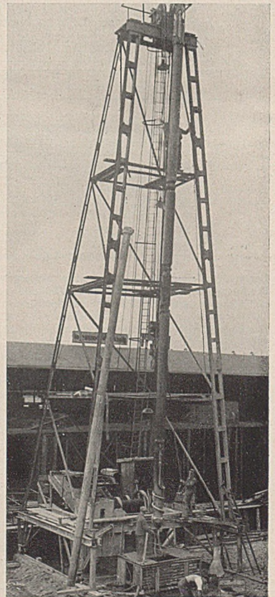
Abb. 3. Ansicht des Bohr- und Verdichtungsgerätes.
