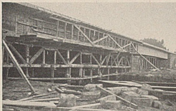
Abb. 12. Lehrgerüst eines Tragwerkes (Im Hintergrund ein ausgeschalteter fertiger Balken).
