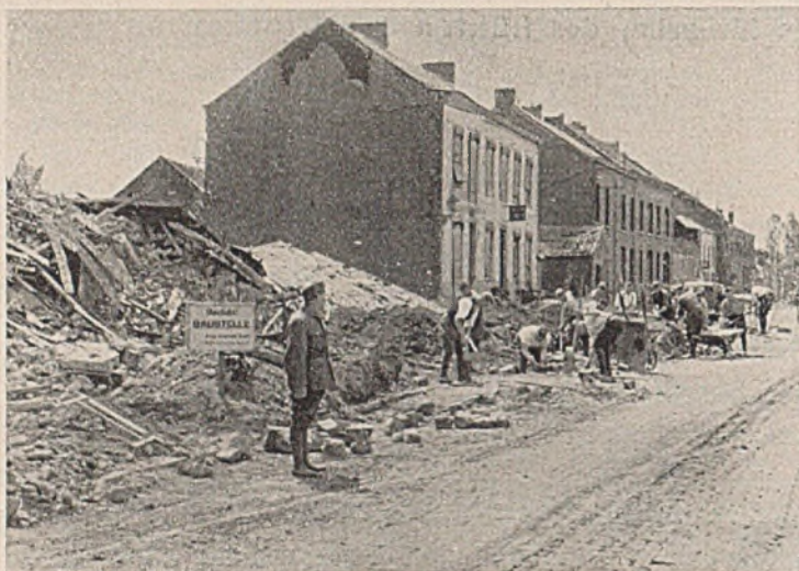
Abb. 4. Aufräumen einer Straße.
