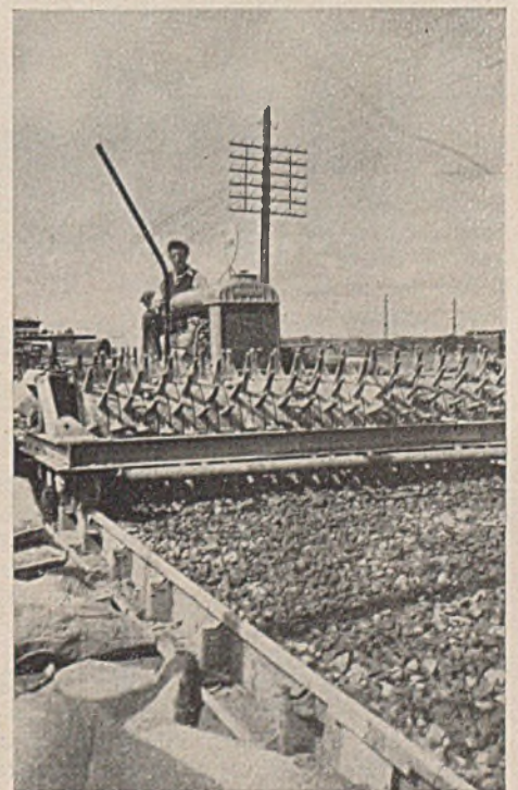
Abb. 4. Holterbeton-Stachelwalze zur Durcharbeitung des Schotters mit dem Mörtel.
