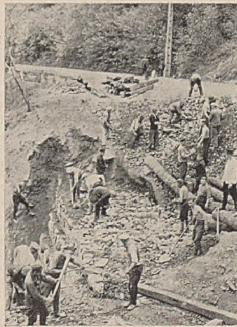
Abb. 2. Ausfüllen eines Sprengtrichters an einer Straße.
