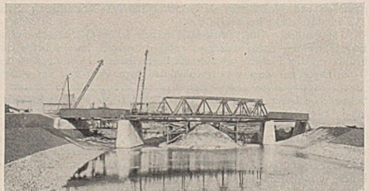
Abb. 15. Aufstellen der Brücken.
