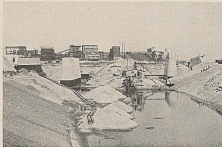
Abb. 9. Blick in die Baugrube mit den fertigen Pfeilern und Widerlagern.
