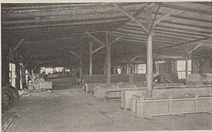
Abb. 6. Inneres einer heizbaren Werkstatthalle.
