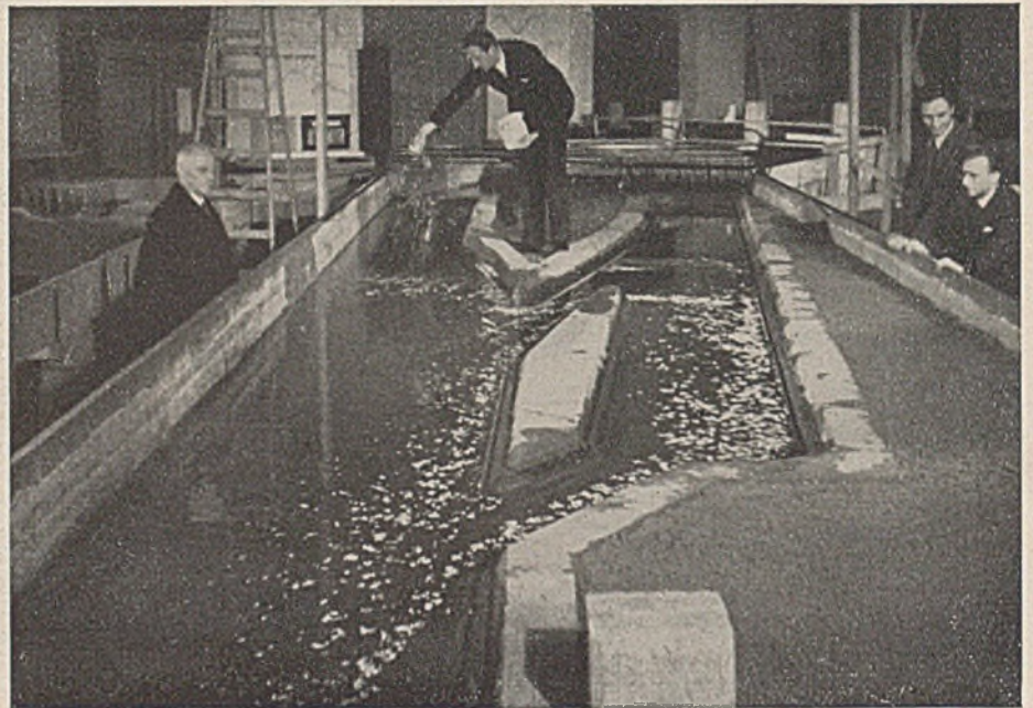
Abb. 2. Modellversuche in der Wasserbauversuchsanstalt der Techn. Hochschule in Budapest. Die eingestreuten Papierschnitzel zeigen die Richtung der Strömung. Aufn.: L. Nagy, MFI.
