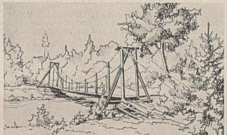
Abb. 3. Nordischer Hängesteg mit über Holzböcke gespannten Seilen.
