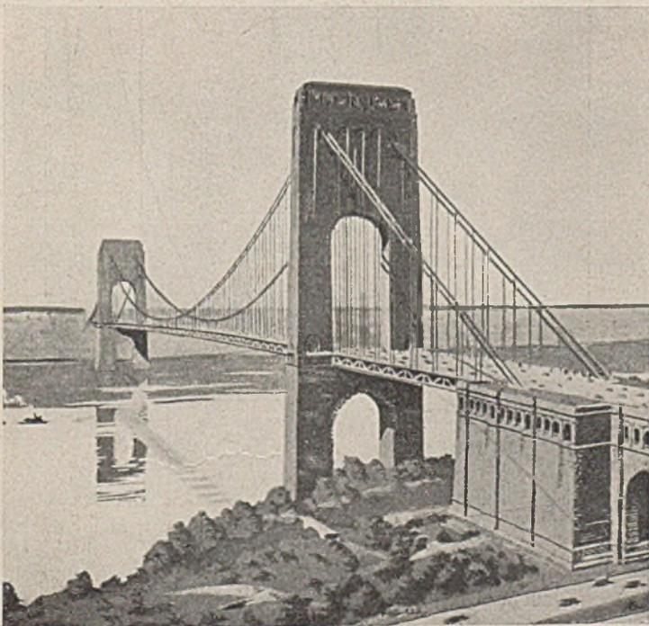
Abb. 33. Die vom Architekten vorgesehene Steinverkleidung der Stahltürme der Washingtonbrücke.
