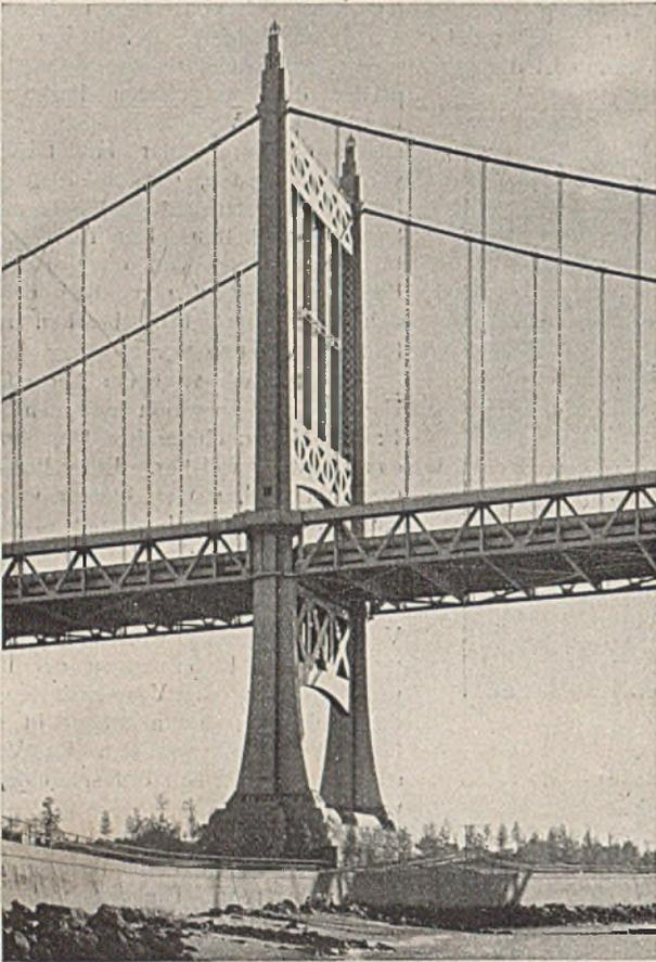
Abb. 41. Stahlpfeiler der Triboroughbrücke über den Eastriver in New York.
