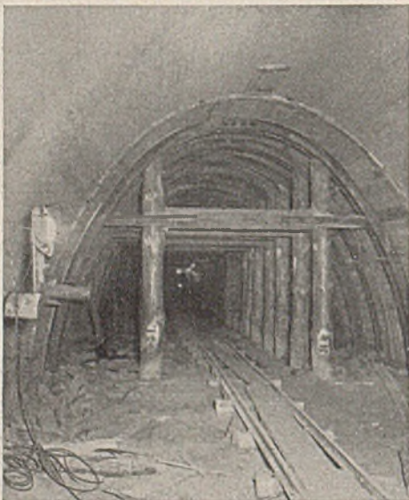
Abb. 6b. Lehrbogen mit Holz versteift. Kalottengewölbe betoniert.
