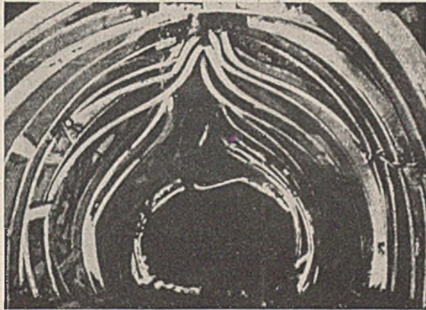
Abb. 9. Verformte Stahlbögen.
