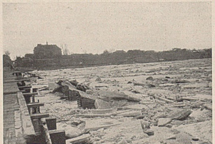
Abb. 4. Hochwasser mit starkem Treibeis auf der Warthe bei Posen. März 1940.
