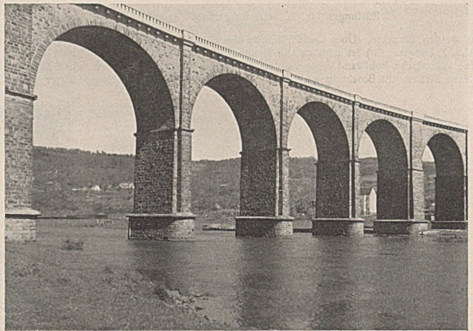
Abb. 17. Das fertige Bauwerk.
