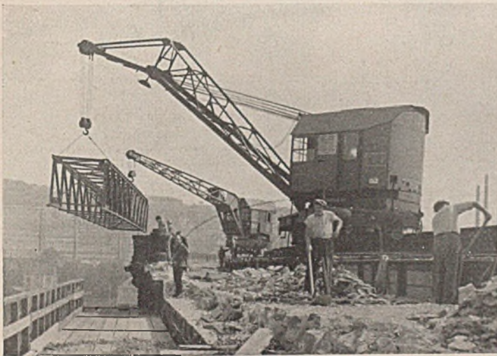
Abb. 10. Einsetzen eines Fachwerkträgers der Rüstung.
