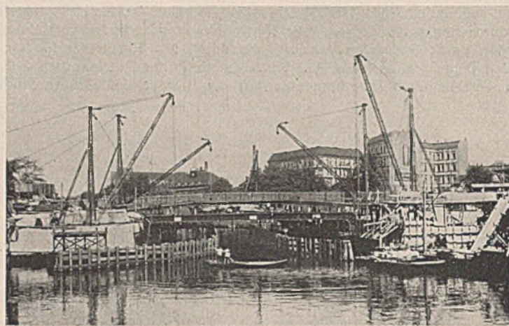
Abb. 13. Einbau der Hauptträger.
