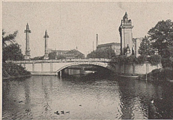
Abb. 1. Ansicht der alten Brücke von Süden.
