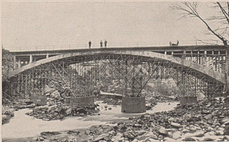
Abb. 45. Rohrgerüst für eine Eisenbetonbrücke (Innocenti, Italien).
