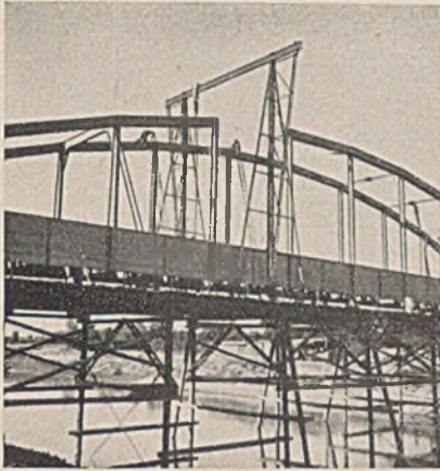
Abb. 13b. Einbau des Bogens.
