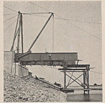
Abb. 14a. Einbau des ersten Feldes des Hauptträgers.
