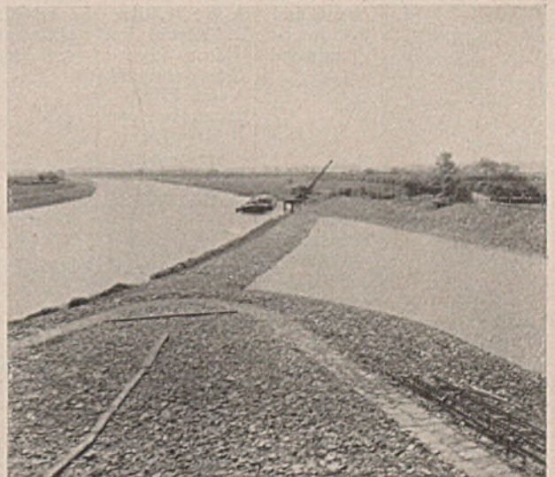
Abb. 8e. Grundschwelle an der oberen Abzweigung.
