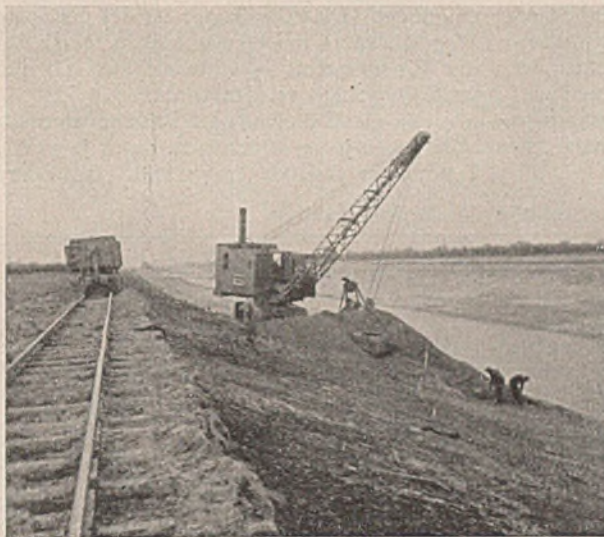
Abb. 8b. Beseitigung der Berme für den Eimerkettenbagger durch einen Schürfkübelbagger.
