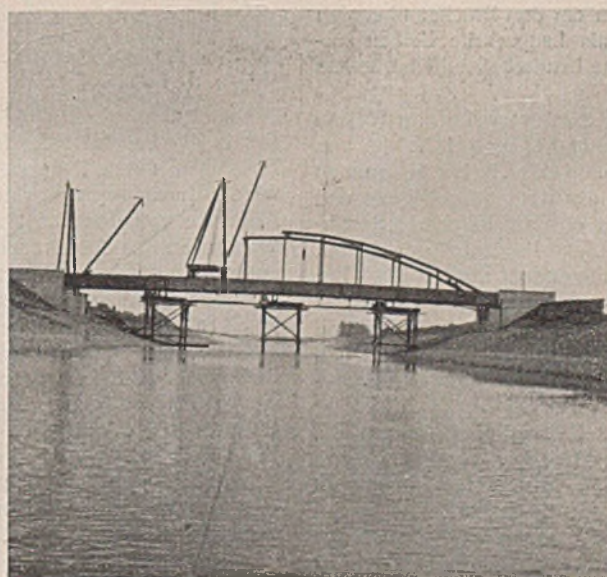
Abb. 14e. Einbau des Bogens.
