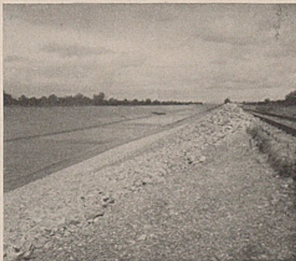
Abb. 8d. Einbau der Uferbefestigung.
