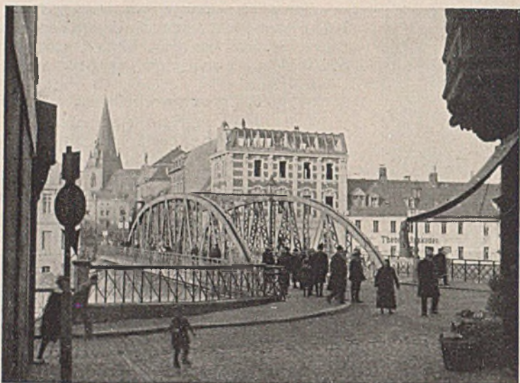
Abb. 5. Im Jahre 1891 erbaute elserne Brücke vom rechten Ufer.
