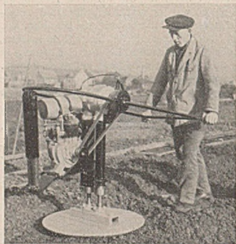
Rüttelstampfgerät mit Antrieb durch einen Verbrennungsmotor zum Verdichten loser Schüttungen.
