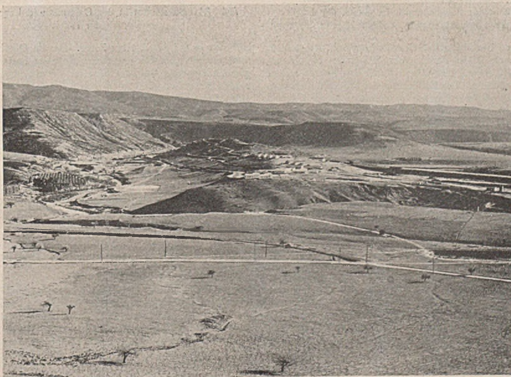
Abb. 32b. Talseitige Ansicht der Sperrstelle, rechts der Hochwasserdamm.
