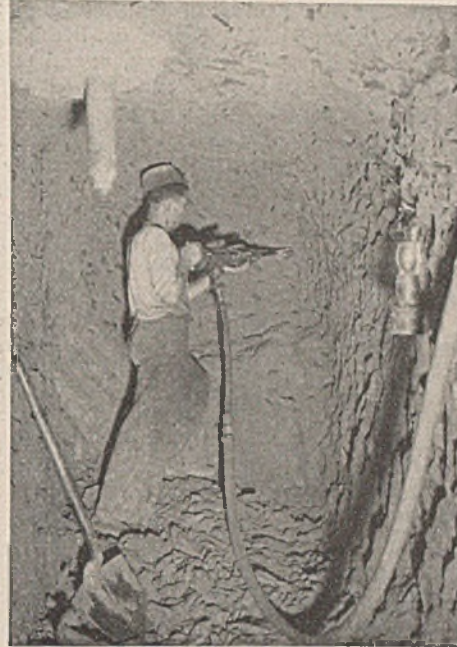
Abb. 31. Herstellung des Entwässerungsstollens bei Mostaganem, im First erkennt man den fertiggestellten, noch abgedichteten Filterbrunnen.
