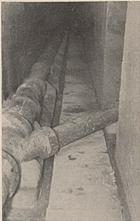
Abb. 16. Bauwerk III, Einmündung eines Seitenkanals in den Hauptkanal.
