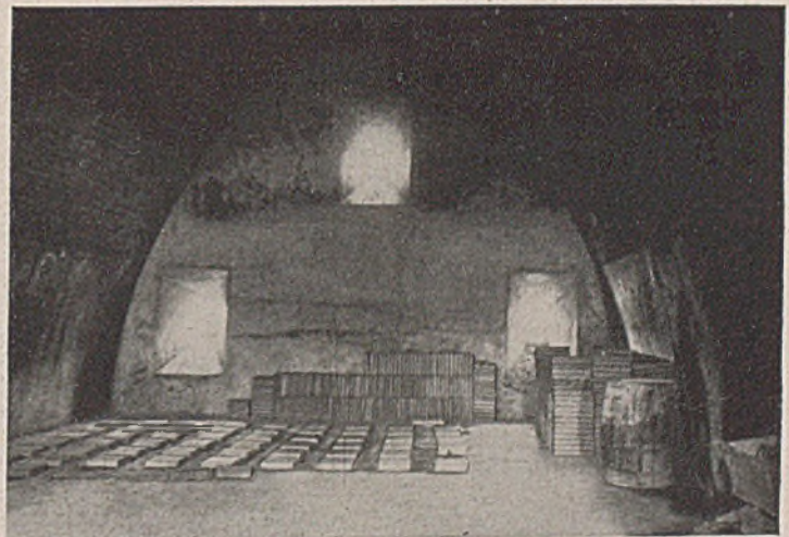
Abb. 35. Bauwerk V, Entlüftungsöffnungen des Hohlraumes über dem Pfeiler, von innen gesehen.
