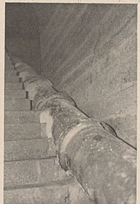
Abb. 17. Bauwerk III, das stark abfallende Endstück der Hauptabflußleitung.
