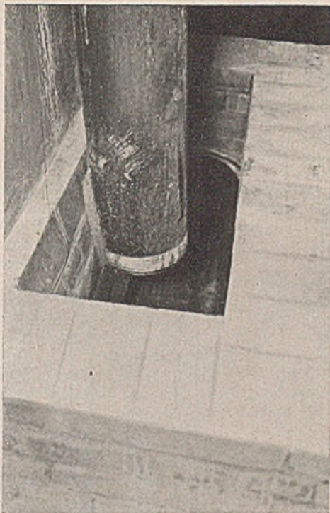
Abb. 33. Bauwerk V, Einführung des Fallrohres in den Schrot im Entwässerungskanal.
