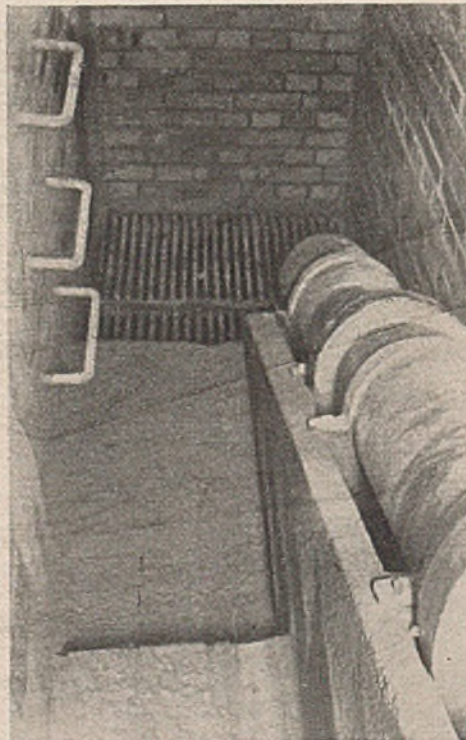
Abb. 22. Bauwerk IV, das Ende der Hauptentwässerungsleitung im Schrot außerhalb der Brücke.
