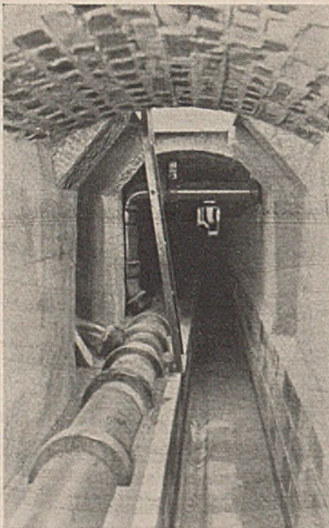
Abb. 21. Bauwerk IV, der Hauptentwässerungskanal an einer Einsteigöffnung. Einmündung zweier Zuflußleitungen.
