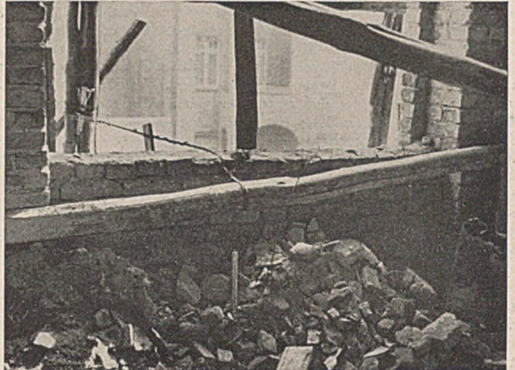
Abb. 16. Die Verankerung der Gerüste an Querlegern in Öffnungen muß beim Fenstereinsetzen umgespannt werden. Zweckmäßiger sind daher eingemauerte Verankerungsbügel.
