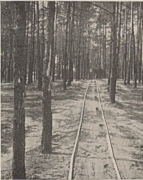
Abb. 20. An diesem zu nahe am Gleis stehenden Baum wurde ein Arbeiter schwer zerquetscht (siehe § 147 der Unfallverhütungsvorschriften).
