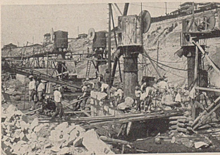
Abb. 11. Druckluftarbeiten für die Pfeilergründungen.
