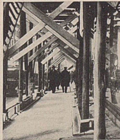
Abb. 14. Rüststangen, die nicht eingegraben werden können, müssen in anderer Weise so befestigt werden, daß sie ihre Lage nicht verändern können (siehe § 48 und Nachtrag der Unfallverhütungsvorschriften).
