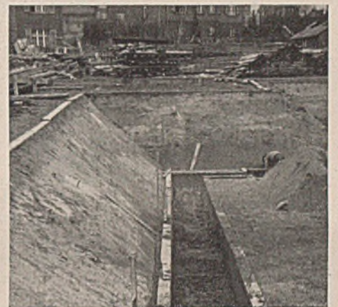
Abb. 5. So muß eine Baugrube mindestens aussehen. (Aber auch hier fehlt noch zwischen Böschungsfuß und dem Aushub für die Grundmauern der Arbeitsraum.)
