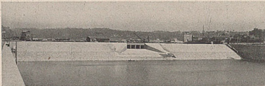
Abb. 15. Entlastungsbauwerk. Einlauf in das Hafenbecken.
