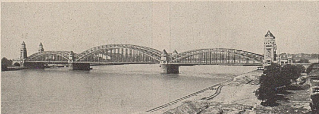
Abb. 3. Strombrücke mit stählernen Bogenträgern.
