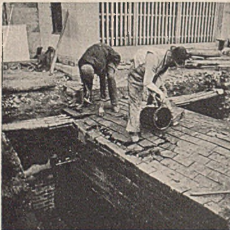
Abb. 4. Dichten der Seitenmauern.
