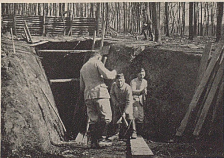
Abb. 2. Bautruppen beim Stollenbau.
