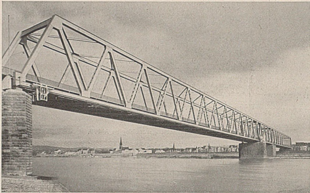
Abb. 14. Strombrücke mit überall gleichhohen Fachwerkträgern.
