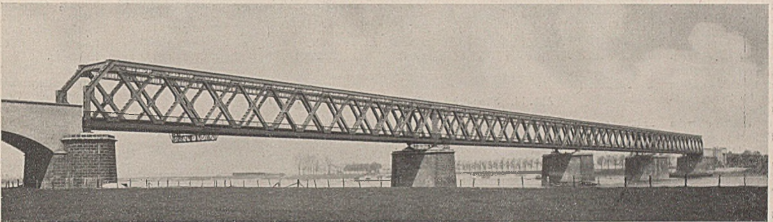
Abb. 11. Strombrücke mit überall gleichhohen Fachwerkträgern.
