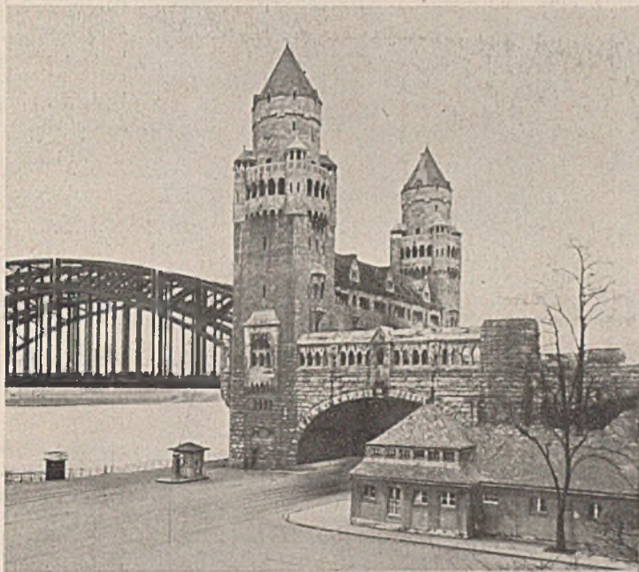
Abb. 4. Endwiderlager der Bogenbrücke in Abb. 3.
