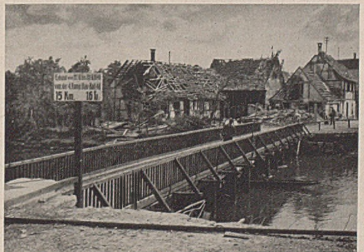
Abb. 4. Brücke für 16 t Last im Kampfgebiet.
