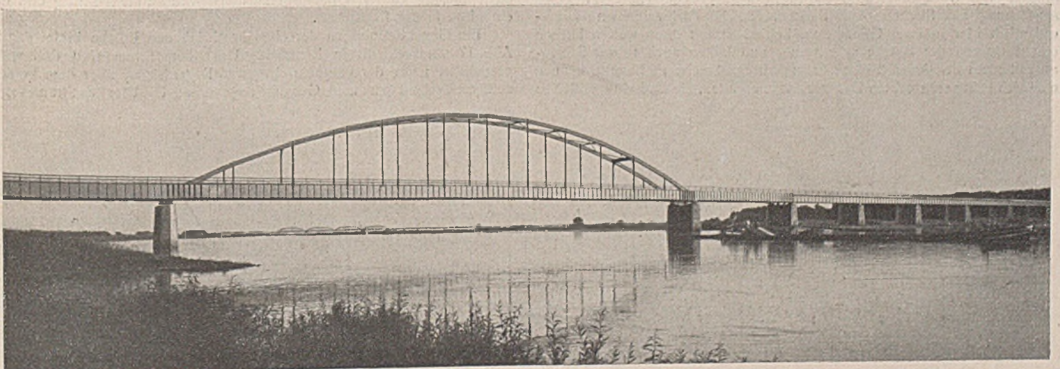
Abb. 13. Stählerne Strombrücke mit versteiftem Stabbogen über der Hauptöffnung.
