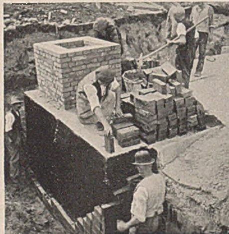
Abb. 5. Dichten der Seitenmauern.
