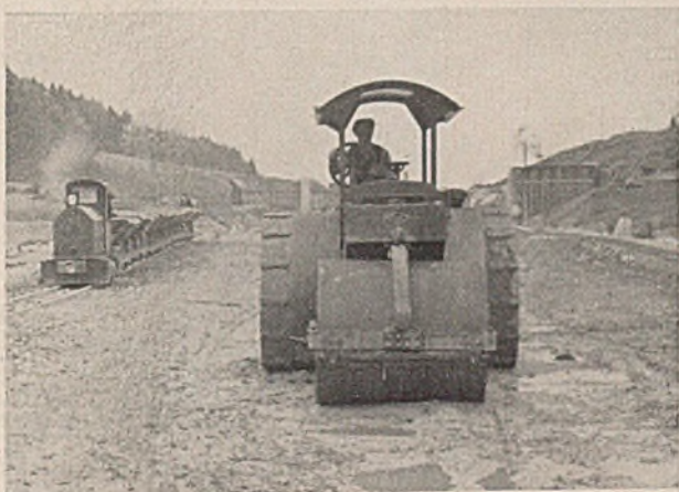
Abb. 2. 8,2-t-Dieseldreiradwalze mit Verbreiterungsringen (je 250 mm) und Greifern an den Hinterrädern.
