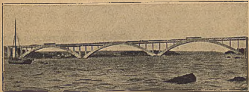
Ryc. 2. Most na rzece Elorn w Plongastel. Pręśla żelbetowe.
