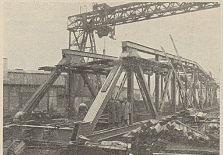
Abb. 14. Brücke in der Werkstatt zusammengebaut.
