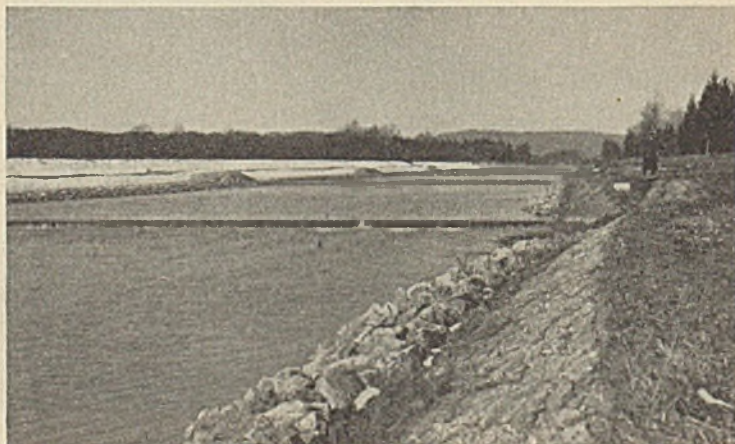
Abb. 71. Mangfallkorrektur zwischen Westerham und Heufeld von km 28,0 bis 14. Blick aufwärts von der Schwelle 132 bei km 23,6.
