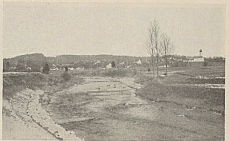
Abb. 73. Unterhalb km 27 sind wegen der leicht verwitterungsfähigen Flinzschieben und des geringen Gefälles (ungefähr 3 ‰) nur einfache örtliche Uferschutzbauten.
