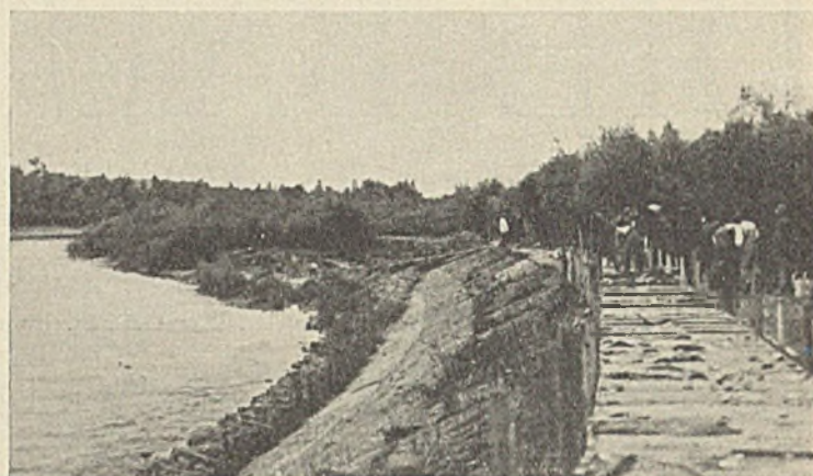
Abb. 69. Alz km 22,2 links unterhalb Hirten. Betonieren einer Betonschlaue zu Wasserbausteinen.
