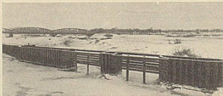
Abb. 14. Die Trennmole im Winter. Die Kasten noch nicht fertig verfüllt.
