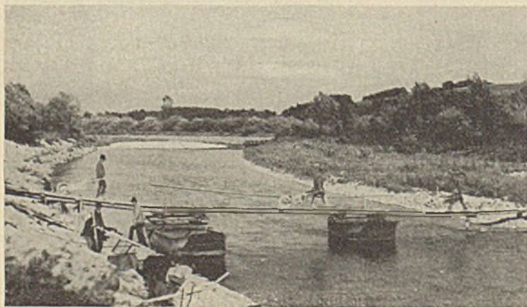
Abb. 70. Alz km 30,4 links unterhalb Burgkirchen. Böschungsversteinerung.
