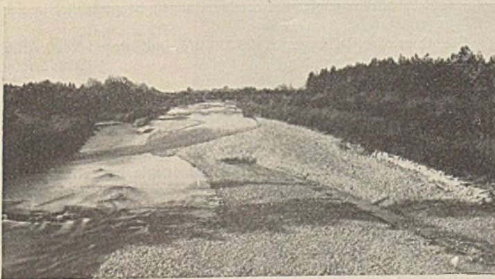
Abb. 74. Mangfallkorrektur zwischen Heufeld und Kolbermoor bei km 14 bis 8.
