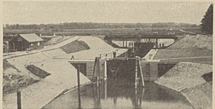
Abb. 18a. Die fertige Schleuse vom Unterkanal aus gesehen.
