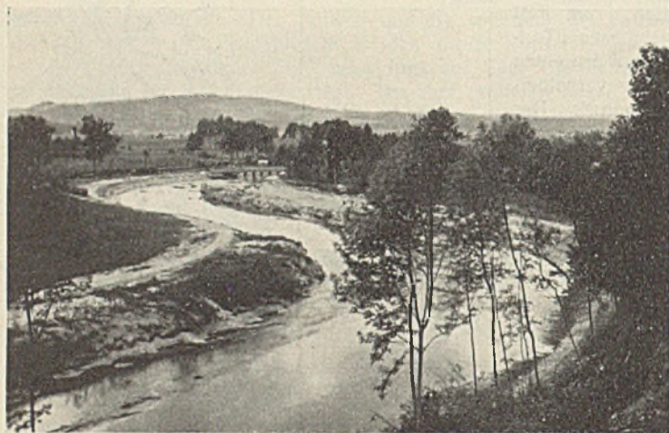
Abb. 44. Oberes Ende Los II. Blick flußabwärts.
