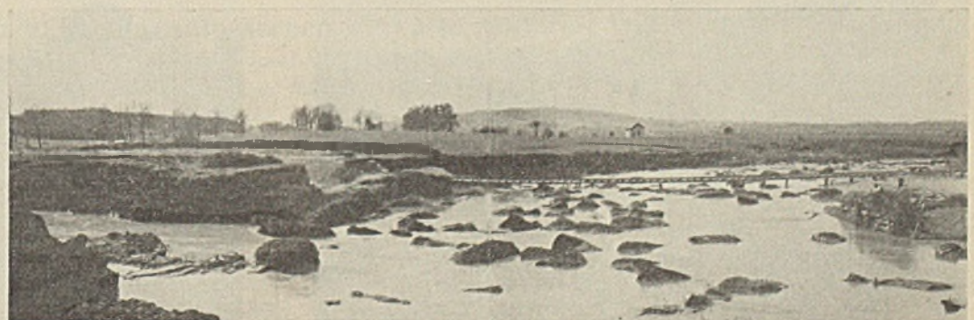
Abb. 41. Ammerkorrektur. Unteres Ende des Durchstiches I (Torfdurchstich) kurz nach dessen Öffnung.
