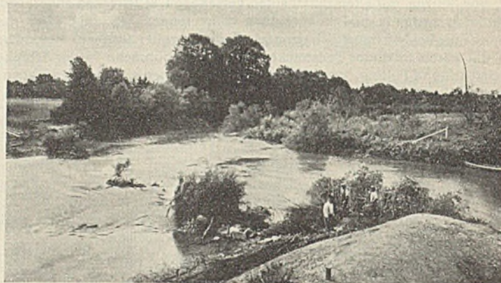
Abb. 45. Fertiger Durchstich bei Oderding. Altes Bett noch offen, Blick flußabwärts.
