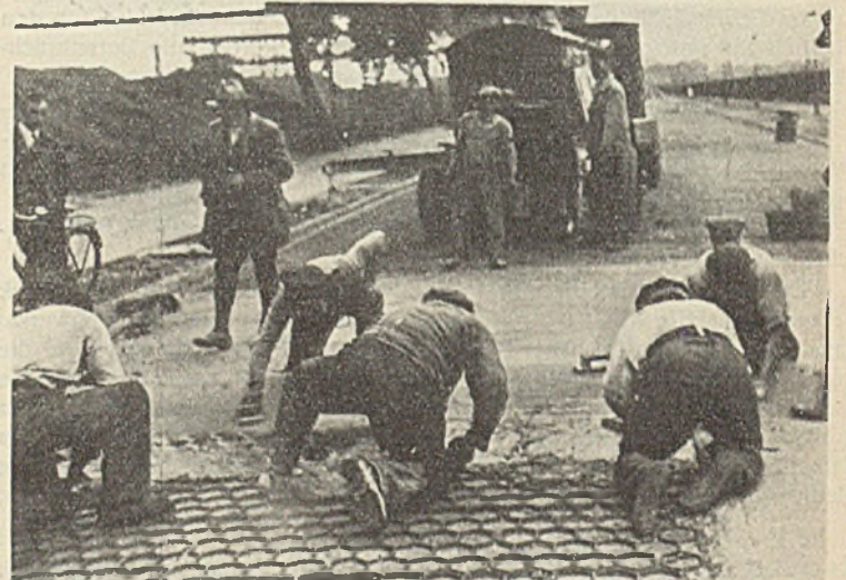
Abb. 4. Ausfüllen und Verstreichen der Roste mit Hartgußasphalt.
