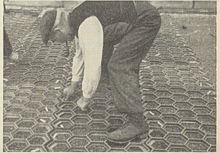
Abb. 2. Das Unterlegen der Roste mit Holzstückchen zur Raumgewinnung für die Untergußmasse.
