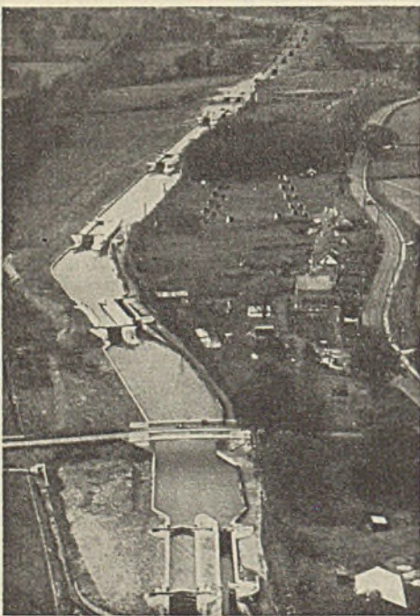
Abb. 2. Schleusenanlage des Grand-Union-Kanals. (Aus Railw. Gaz, 1935, 15. Febr.)
