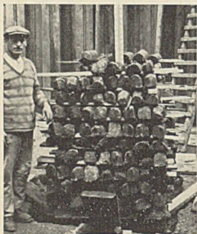
Abb. 5. Versuchsbelastung.
