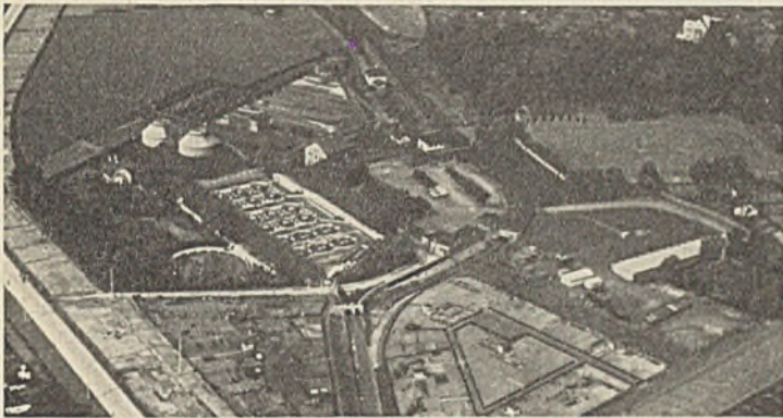
Abb. 1. Luftbild der Kläranlage Essen-Nord. Im Hintergrunde links die beiden neuen Schlammfaulbehälter.
