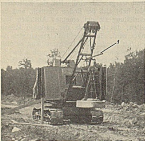
I = Steuerstange. Abb. 1. Durch Druckluft gesteuertes, selbsttätiges Stampfgerät.
