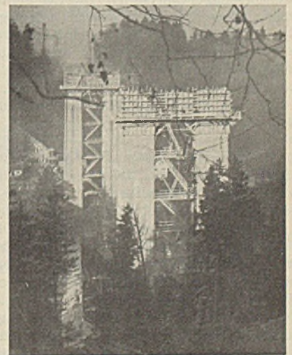
Abb. 20. Betonierung der Riegel.
