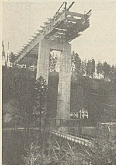
Abb. 26. Vorbau im Mittelfelde. Am Kranhaken ein Hauptträgeroberteil.
