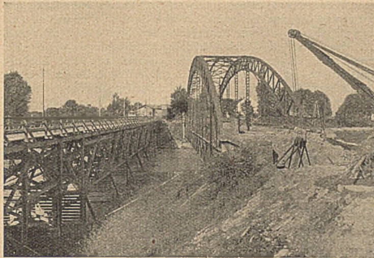
Abb. 22. Notbrücke und alte eiserne Brücke.
