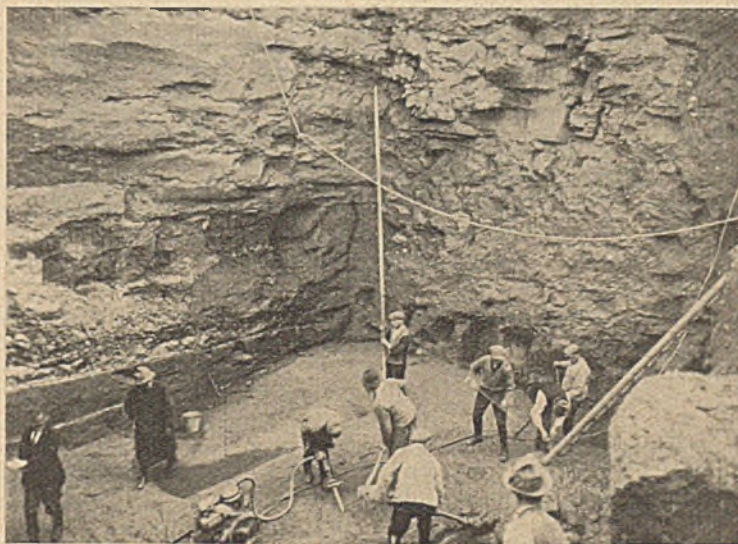
Abb. 9. Streckbrücke, Baugrube des großen nördlichen Widerlagers.
