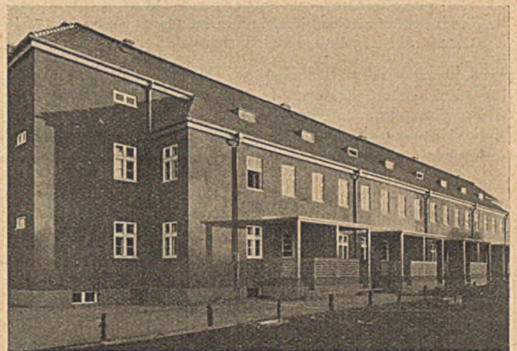
Abb. 8. Siedlung Breslau-Pöpelwitz. Gasbeton-Stahlskelettbau. Torkretputz.
