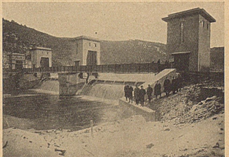
Abb. 16. Wasserkraftanlage der Ford Motor Company (Michigan, USA).
