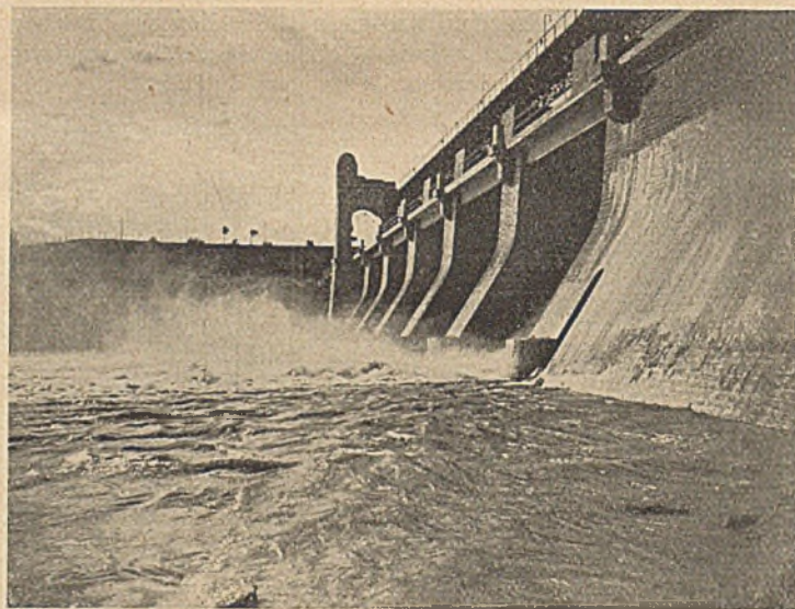
Abb. 19. Wehranlage Cordova (Spanien).
