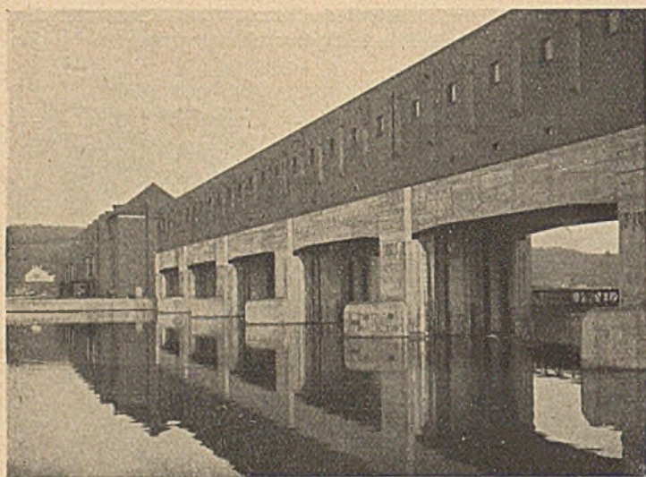
Abb. 17a. Detail Donaukraftwerk Kachlet b. Passau.
