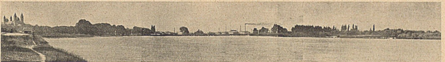
Abb. 54. Ansicht der Baustelle.
