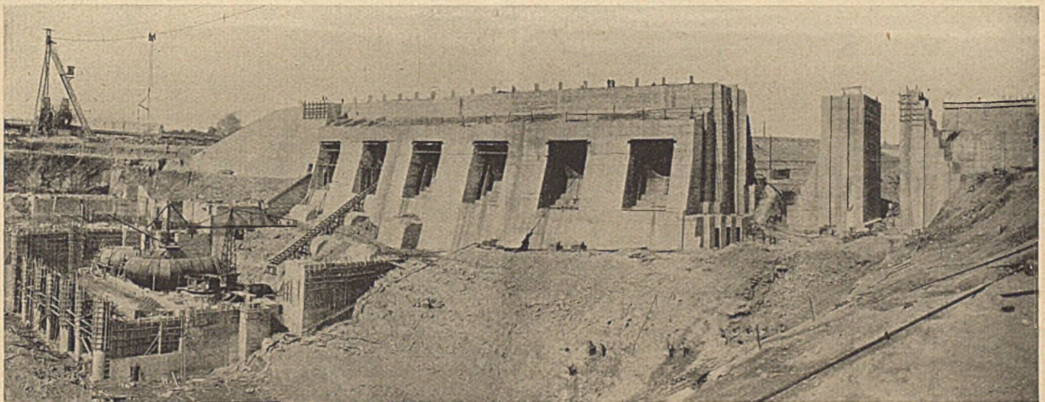
Abb. 15. Wasserschloß und Turbinenrohrbahn im Bau. (7. 3. 1928.)
