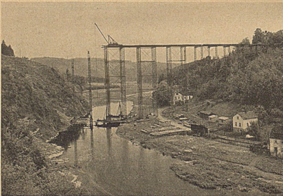
Abb. 4. Zufahrtsbrücke für die Pfeilerbaustellen und Aufstellengerüst für die Stahl-Überbauten.
