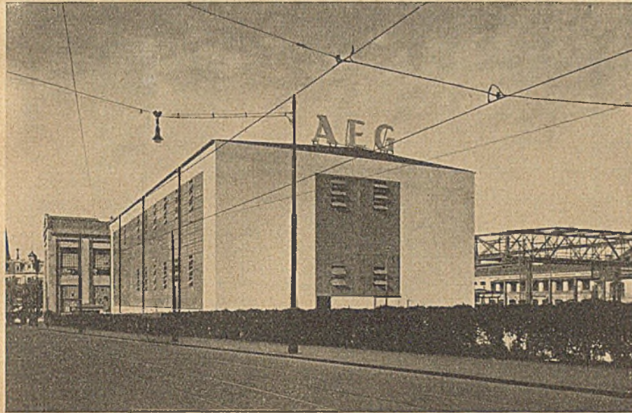
Abb. 1. Straßenseitige Längs- und Giebelansicht.
