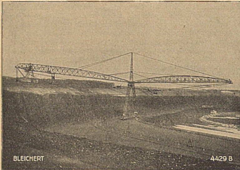
Abb. 1. Gesamtansicht des Brückenkabelbaggers.
