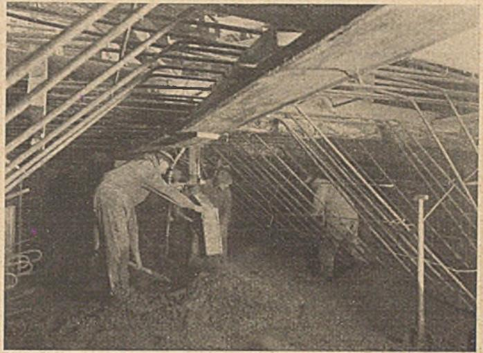
Abb. 2. Düse bei der Betonförderanlage am Opernhaus Berlin.
