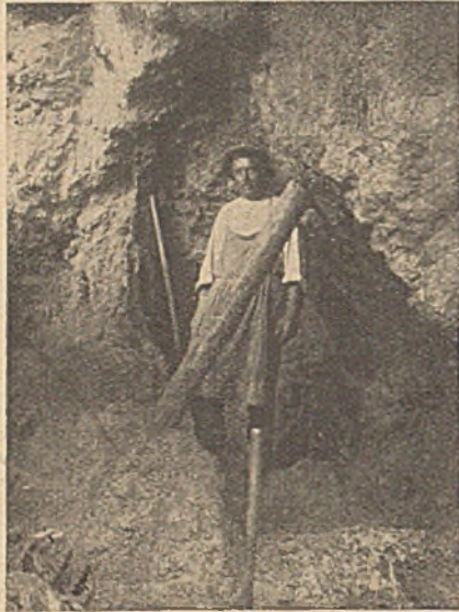
Abb. 5. Aushöhlung im Tuffstein (Baugrube des linken Widerlagers).
