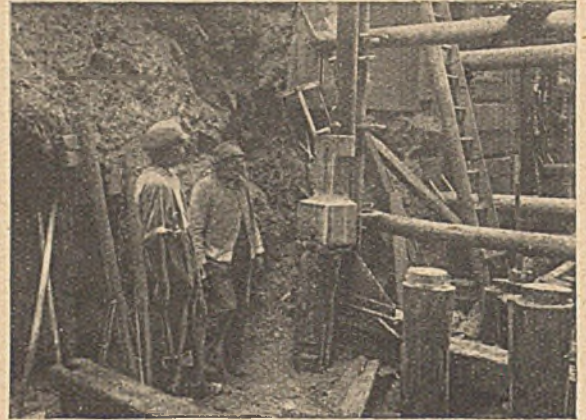
Abb. 6. Teilansicht der Baugrube des linken Widerlagers.
