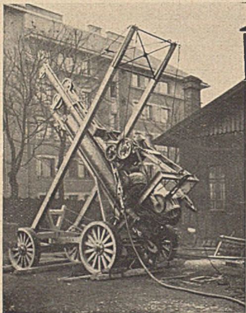
Abb. 12. Umlegung der Grundkörpermaschine für den Transport.
