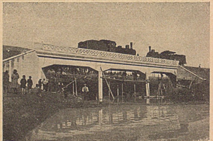
Abb. 6. Brücke bei Rolo für die Hauptbahn Modena—Mantova. (Belastungsprobe.)
