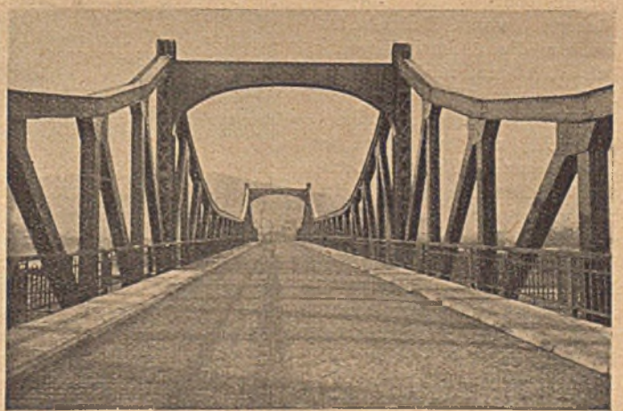
Abb. 6. Straßenbrücke Harkortstraße Hagen i. W.
