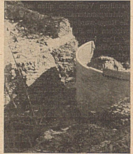
Abb. 1. Blick auf die Wasserseite und auf das linke Widerlager der Moyie-Sperre nach dem Einsturz.
