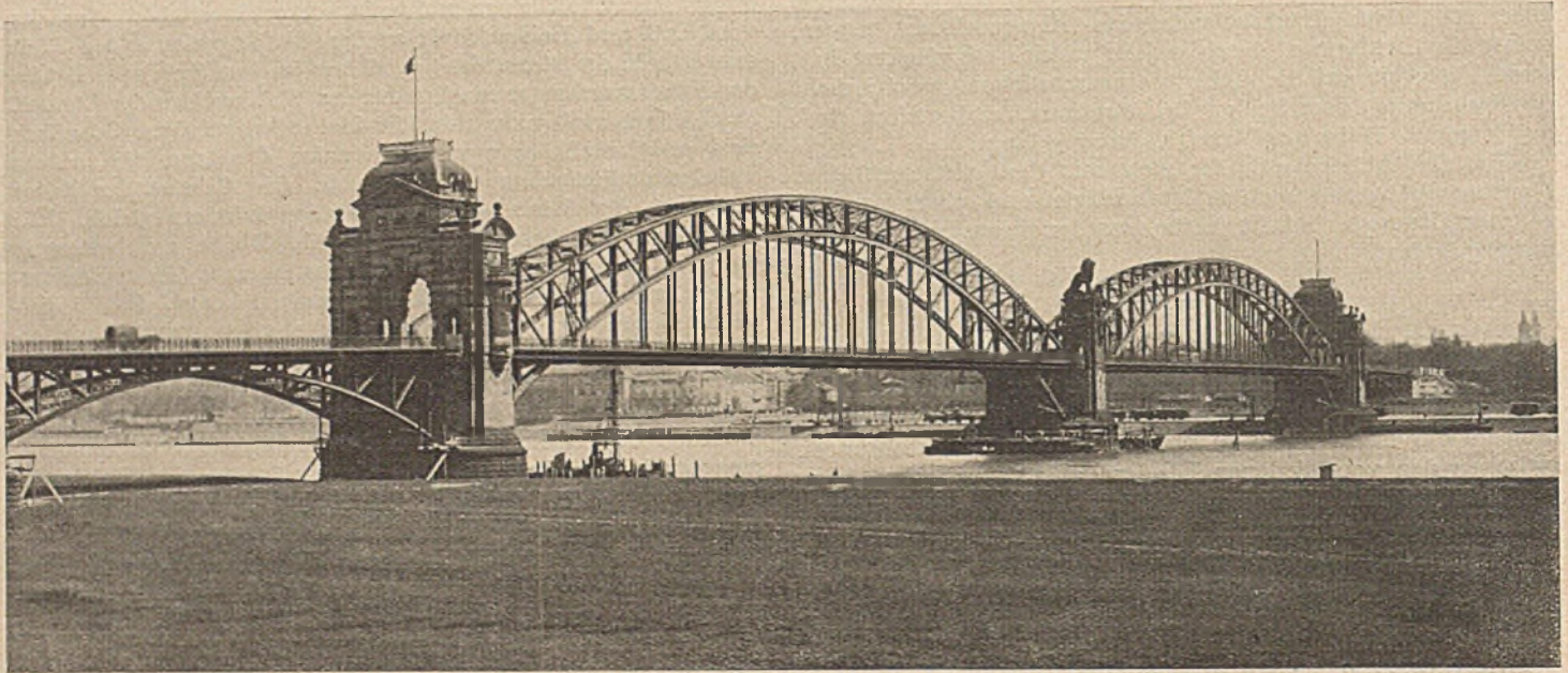
Abb. 1. Vor dem Umbau.
