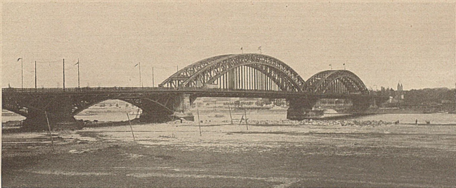
Abb. 2. Nach dem Umbau.
