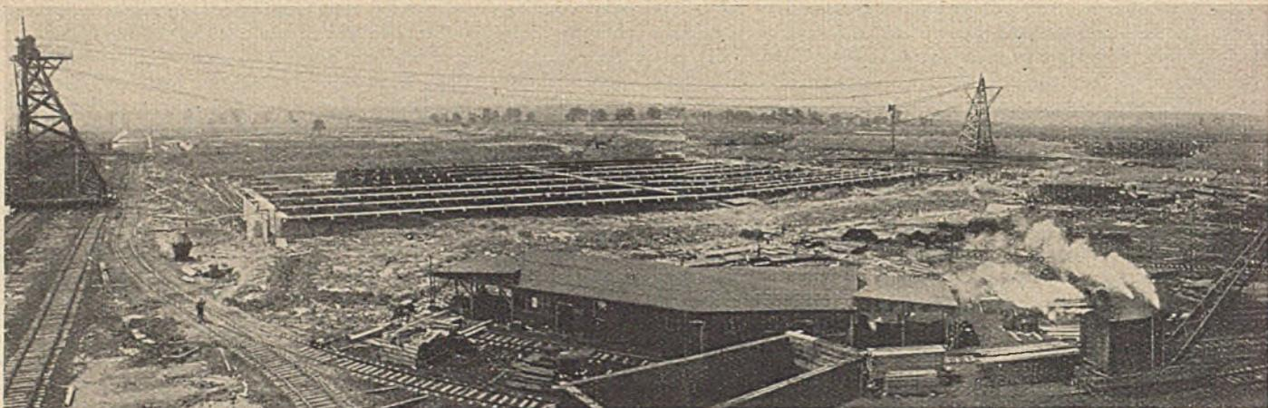
Abb. 2. Parallel fahrbarer Kabelkran (15 t Tragkraft) zum Baue der Klärbecken.
