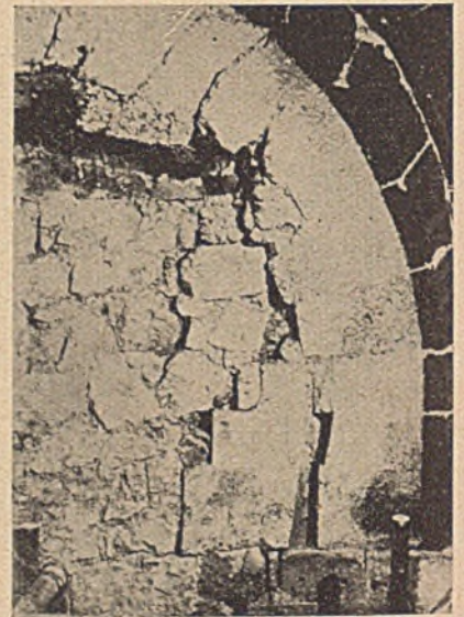
Abb. 6. Abgerissenes Zwickelmauerwerk in den Übergangszwickeln.
