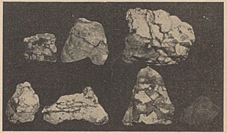
Abb. 13. Stücke von ausgebrochenem Zwickelmauerwerk mit Zementmörteleinpressungen.
