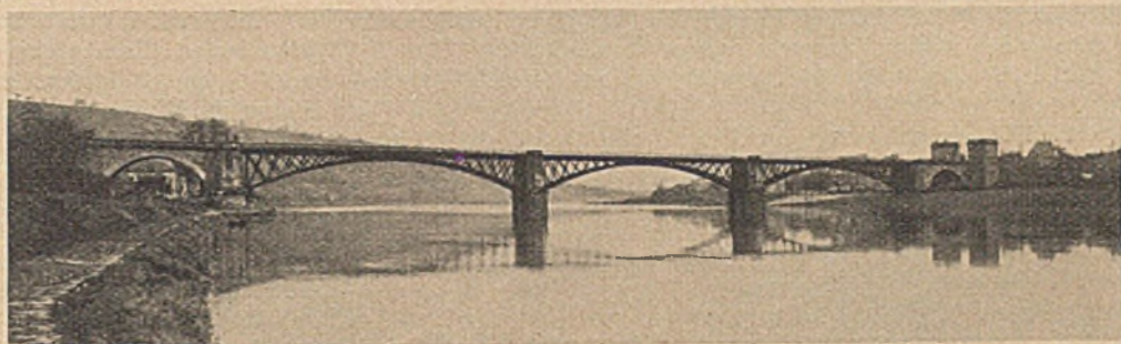
Abb. 3. Ansicht der alten Brücke.
