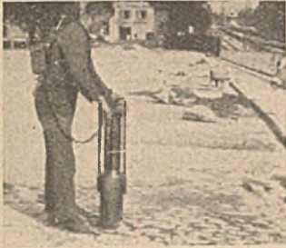
Abb. 8 a. Aufsetzen vor der Zündung.
