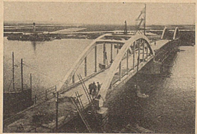
Abb. 9. Die für den vorläufigen Verkehr freigegebene Brücke.
