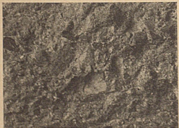
Abb. 7. Bruchfläche eines aus Gußbeton hergestellten Probekalkens.
