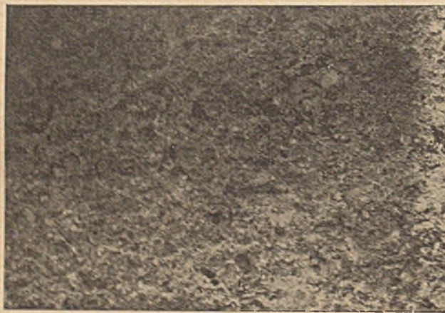
Abb. 6. Betongefüge des Mittelbogens.
