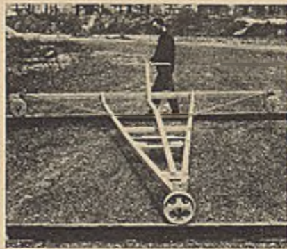
Maschine zum Schneiden von Blindfugen.
