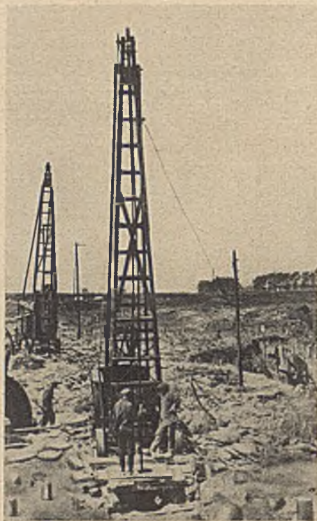
Abb. 3. Tiefseilschlagbohrmaschine zur Herstellung tiefer, großkalibriger Bohrlöcher.
